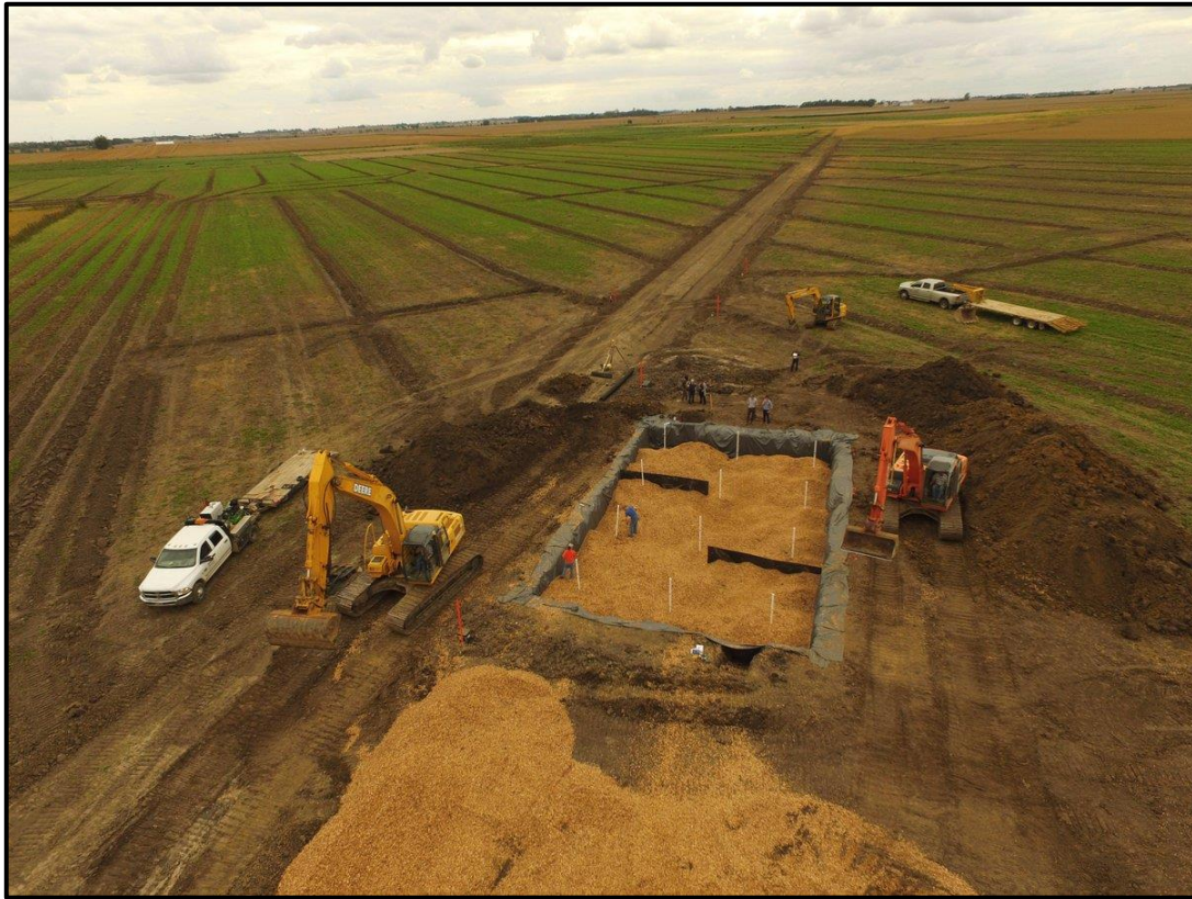
Figura 2. Construcción de un Biorreactor de astillas de madera en un campo de Iowa (EEUU). Foto: N.D. Bowman
