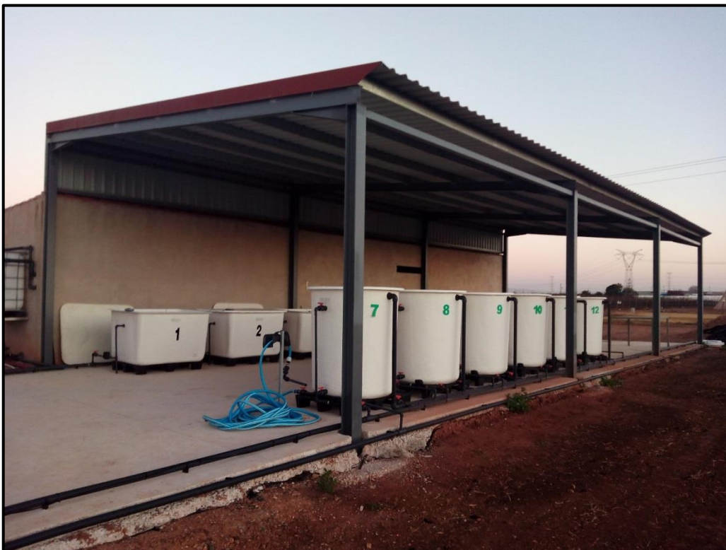
Figura 8. Estado actual de las instalaciones con el porche metálico construido
